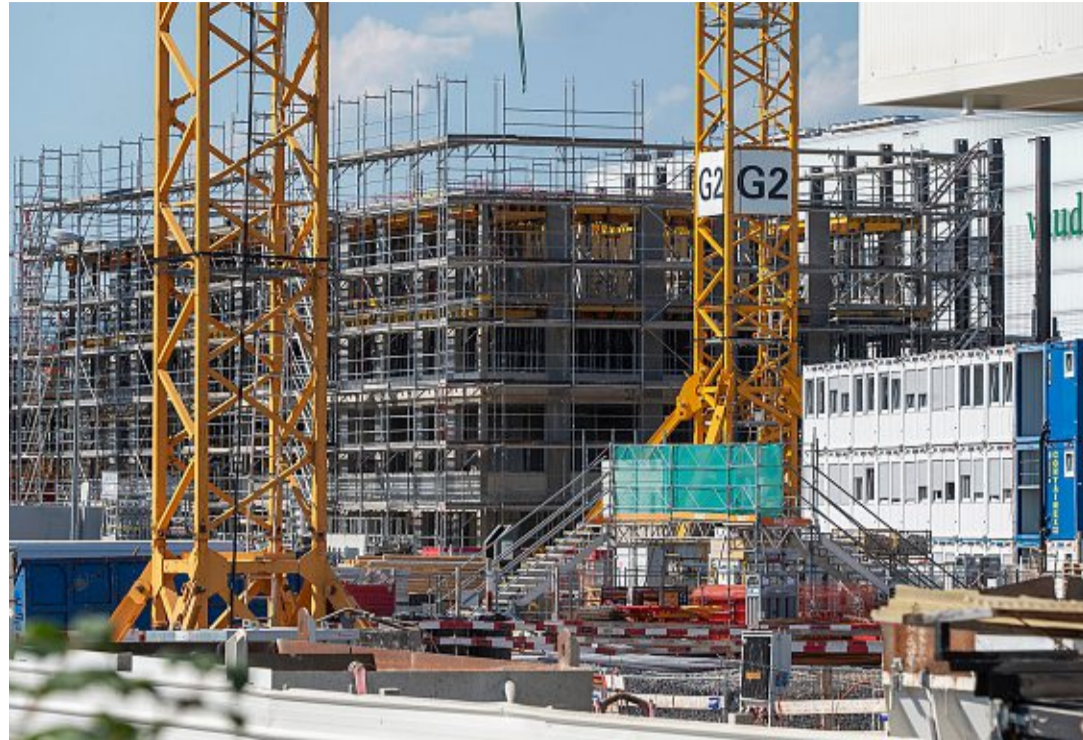
Notre lecteur s'inquiète du bétonnage grandissant du territoire vaudois (ici, Malley).
